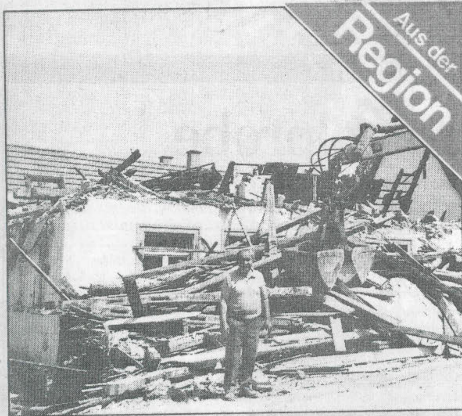
Dem Bagger zum Opfer fiel das Gebäude des über Dietenhausen hinaus bekannten Gasthauses Adler, das seit 1950 von Wirt Herbert Drollinger (76) geführt worden ist. Im Frühjahr soll an gleicher Stelle ein äußerlich dem alten Adler gleichender Neubau unter Leitung seines Sohnes Hans-Peter eröffnet werden. Bild: Ossmann
